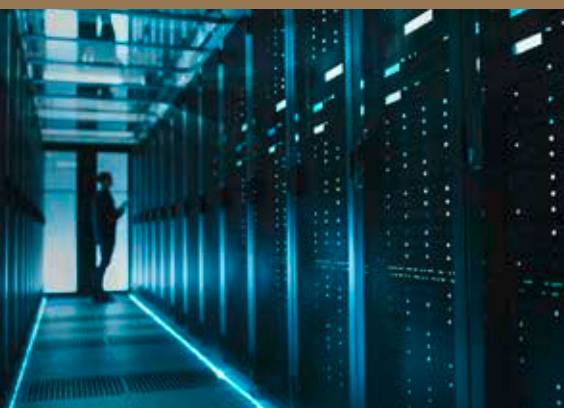
Wärme aus Rechenzentren | Heat from data centers
