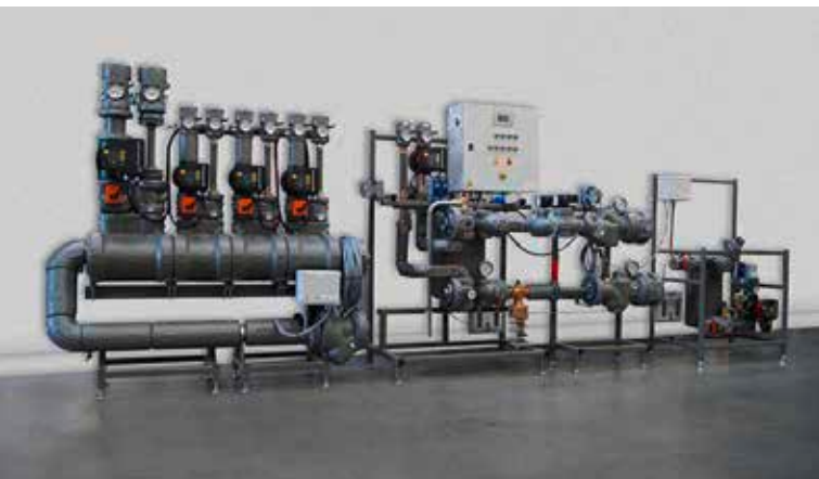
Moderne Fernwärmeübergabestation mit Verteiler für EvKB | Modern district heating transfer station with distributor for EvKB
