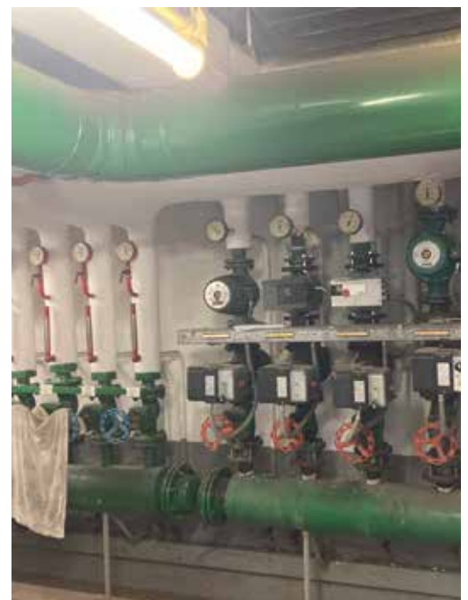
Die alte Gasheizung wurde abgelöst. Foto: ewers
