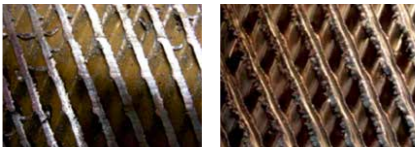
Abbildung 1. Linkes Bild: Sichtmerkmal, Trinkwasser-Kreislauf. Rechtes Bild: Gereinigte Oberfläche
