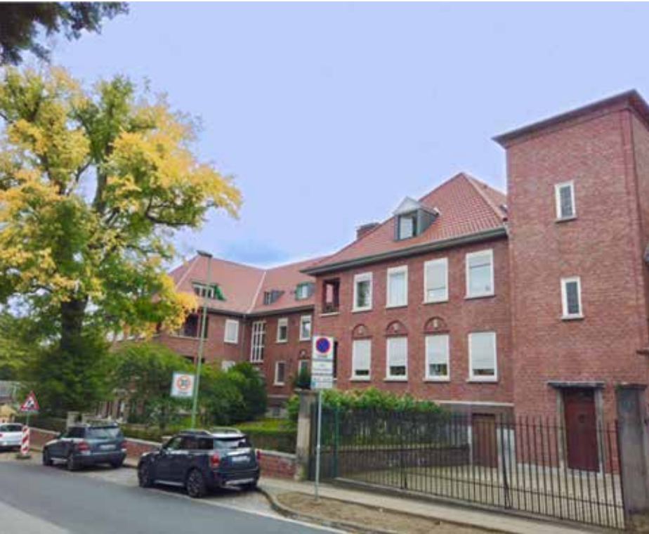
Das denkmalgeschützte Objekt in Bielefeld
