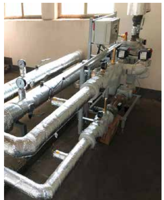
Station für die Fernwärmeübergabe
