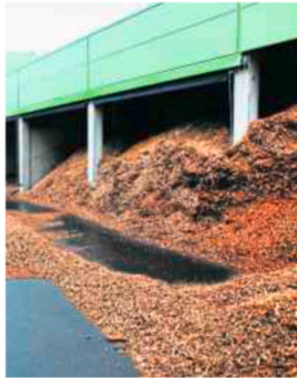
Das Holzheizwerk am Meierhof nahe des Freibades ist der größte Energielieferant für das Verler Fernwärmenetz. Foto: rt
